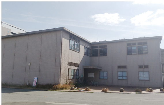
34 生体防御医学研究所4号館(1階部分)
