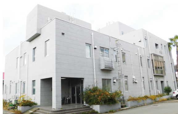
33 生体防御医学研究所3号館
